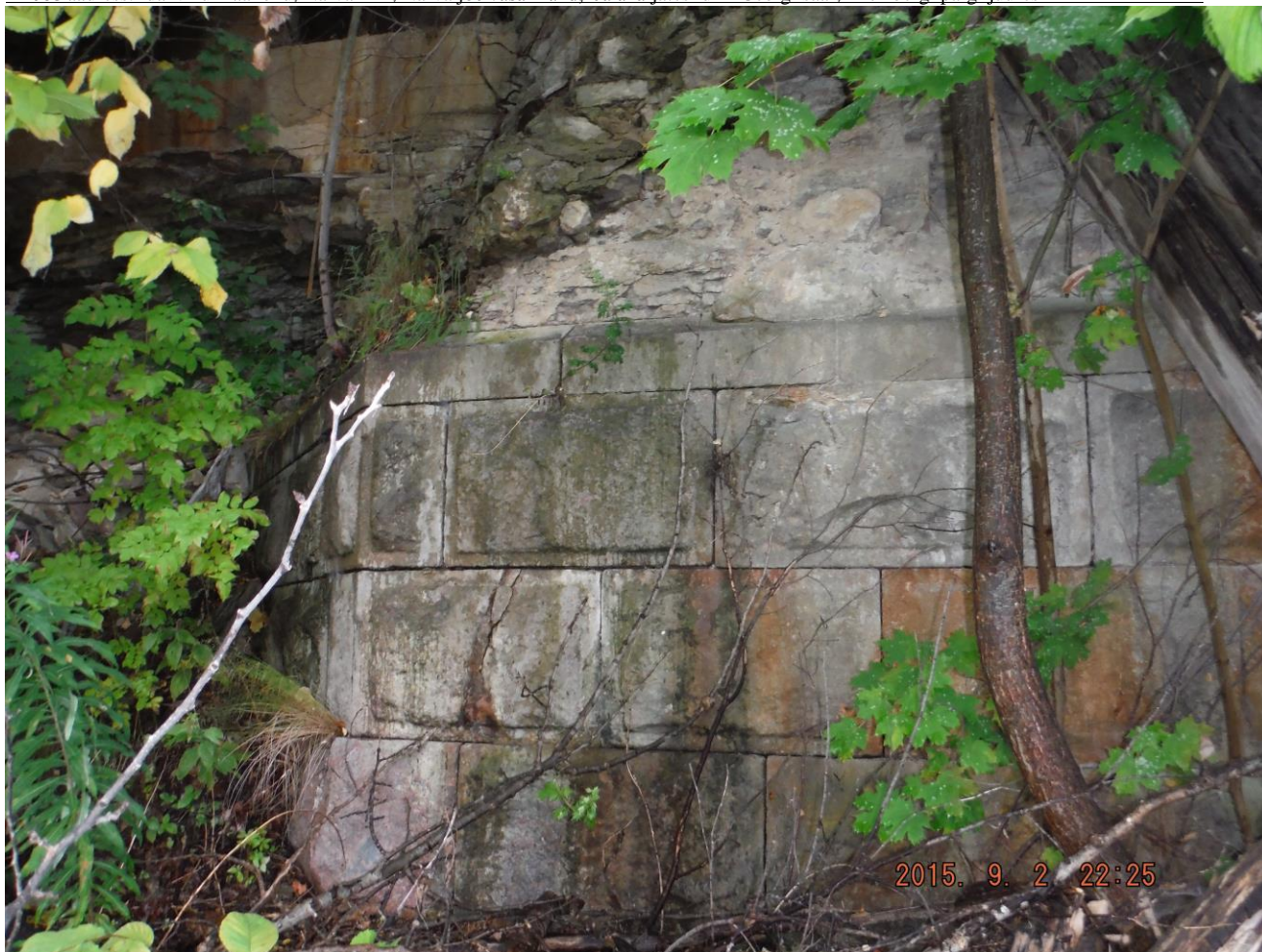
Foto 12. Autor F. S. Vana silla kaldatoetus. Ilus ja tugev müür raudkivist. Raudkivi tugevus 31-42 MPa. Vana aja meistrite korralik kätetöö. Kivide vuugid on sirged ja vuugivahed tihedad.
