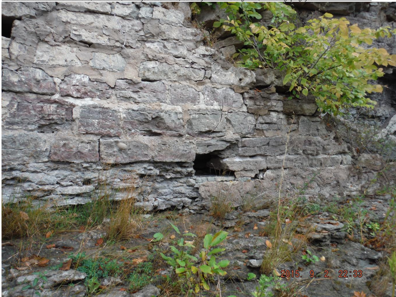
Foto 32. Autor F. S. Müüritise alumises osas on märgata hilisema remondi jäljed. Varasemad remonttööd ei ole andnud soovitud tulemust.
