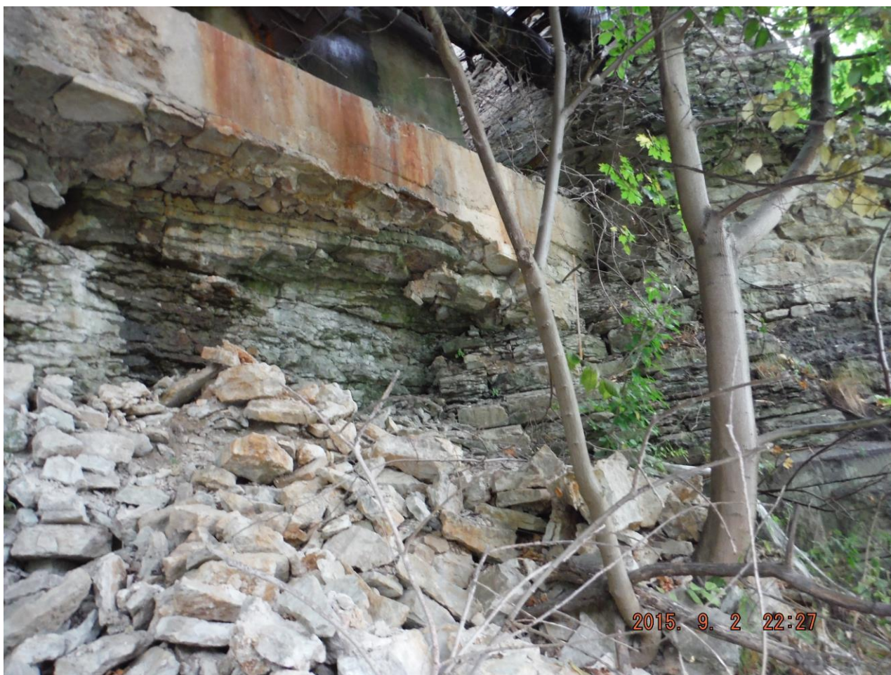
Foto 13. Autor F. S. Olemasoleva silla kaldatugi. Kalju alus on varisenud. Raudbetoonplaat ripub õhus. Paekivi tugevus 21-32 MPa, betooni tugevus 27-31 MPa.
