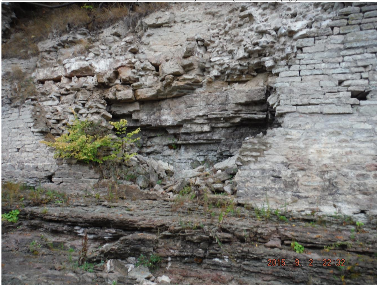
Foto 30. Autor F. S. Tugimüüri lokaalne varing. On näha, et varasemad ehitajad on müüritise ja kalju vahelise osa täitnud kivide ja müüriseguga.
