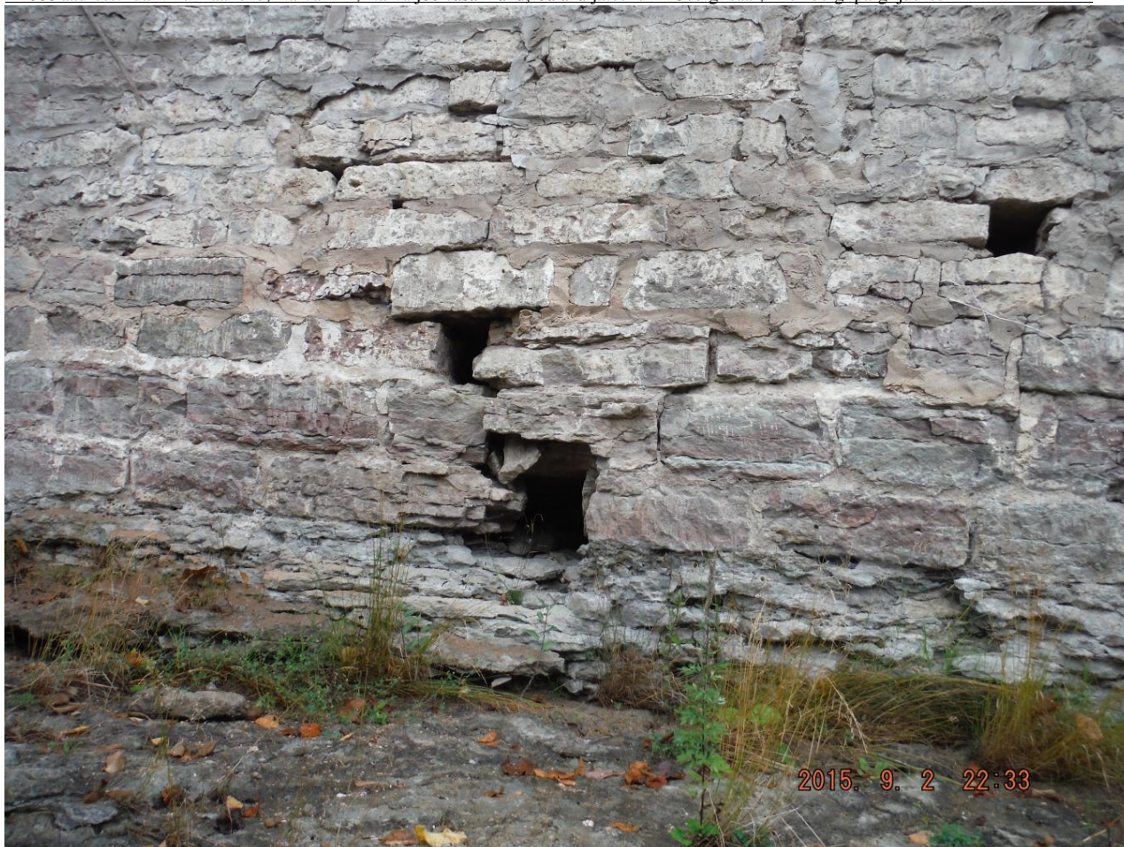
Foto 25. Autor F. S. Drenaaži augud tugimüüris.
