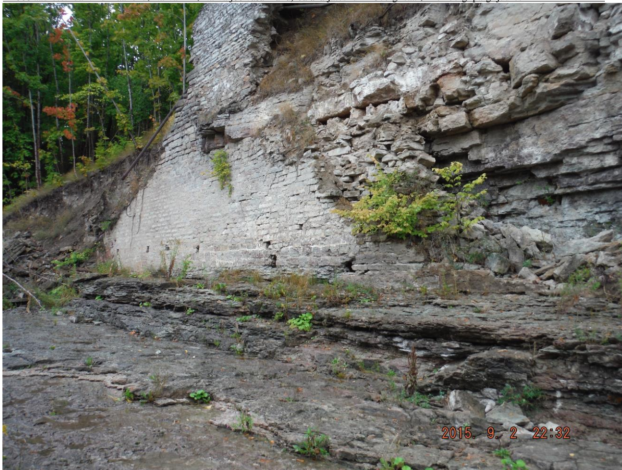
Foto 23. Autor F. S. Tugimüüri varemmed. On näha, et on murenenud ka klindi kalju alumine osa. Müüritise alaosas on näha drenaaži augud pinnasevee ärajuhtimiseks.
