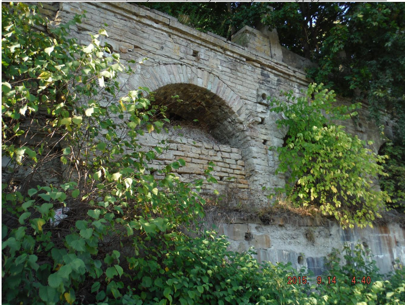
Foto 7. Autor F. S. Praod müüris, näha on konstruktsiooni parandused.
