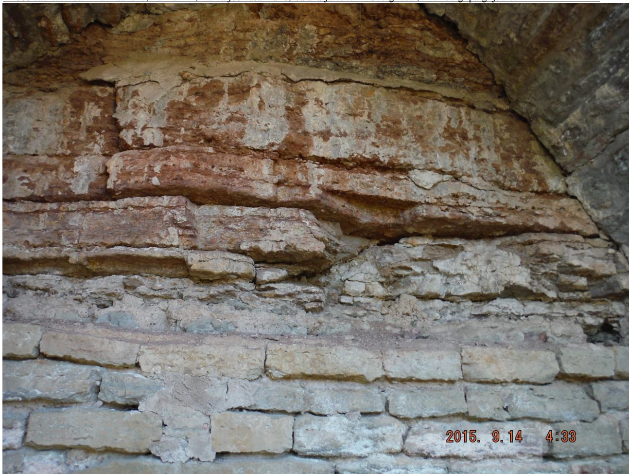
Foto 8. Autor F. S. Müüris on näha hilisemad parandused. Müür on seotud klindi kaljuga.
