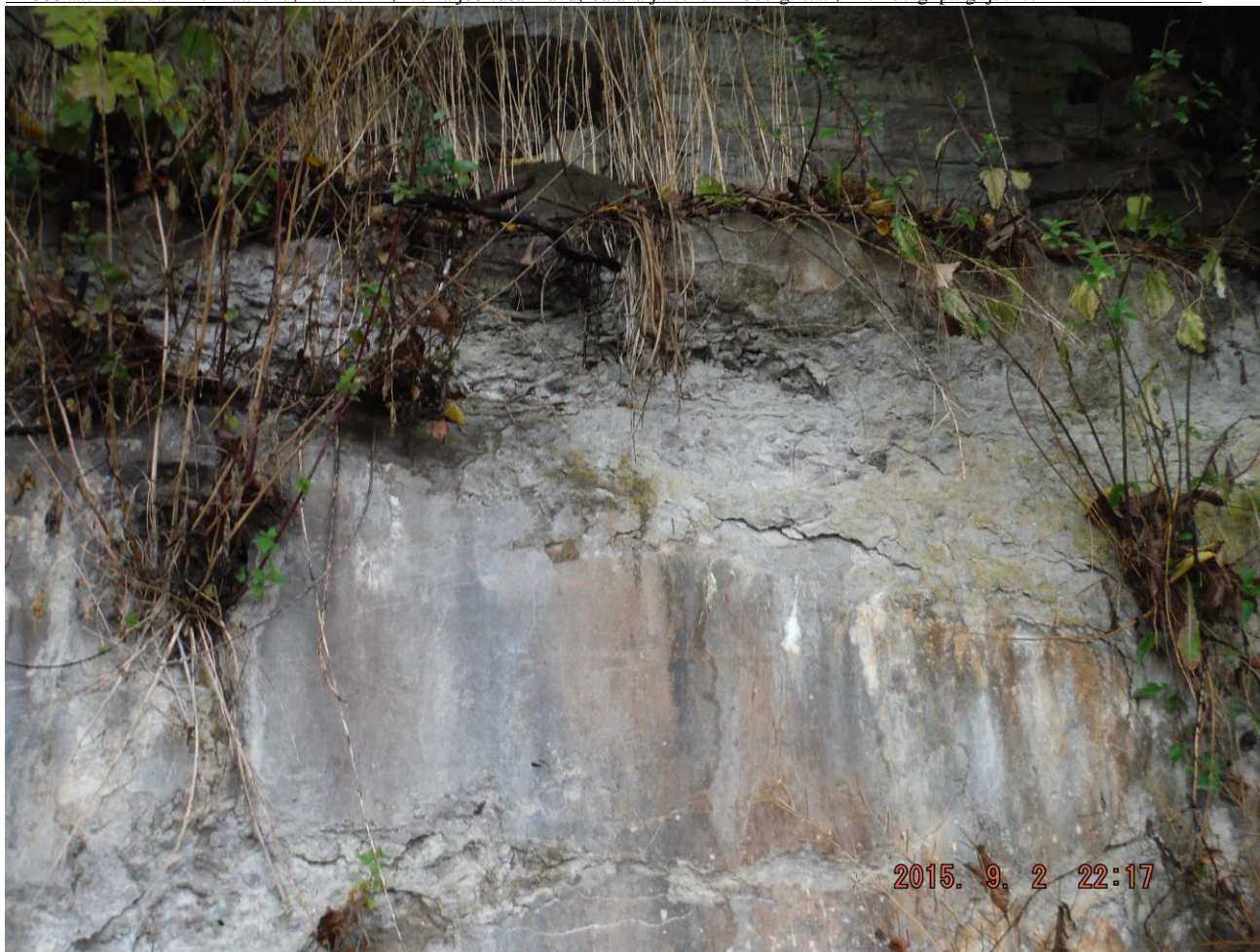
Foto 5. Autor F. S. Tugimüüri sokkel on kaetud taimestikuga ja kahjustunud pinnasevee mõjul. Drenaaziaugud soklis.
