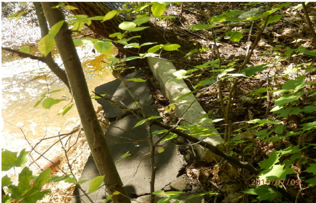
Joonis 5. Tugimüüri äär on jõkke varisenud, pildil müüri servas kulgenud asfaltkattega jalgtee ja äärekivi (konstruktsiooni on sisse kasvanud võsa).
