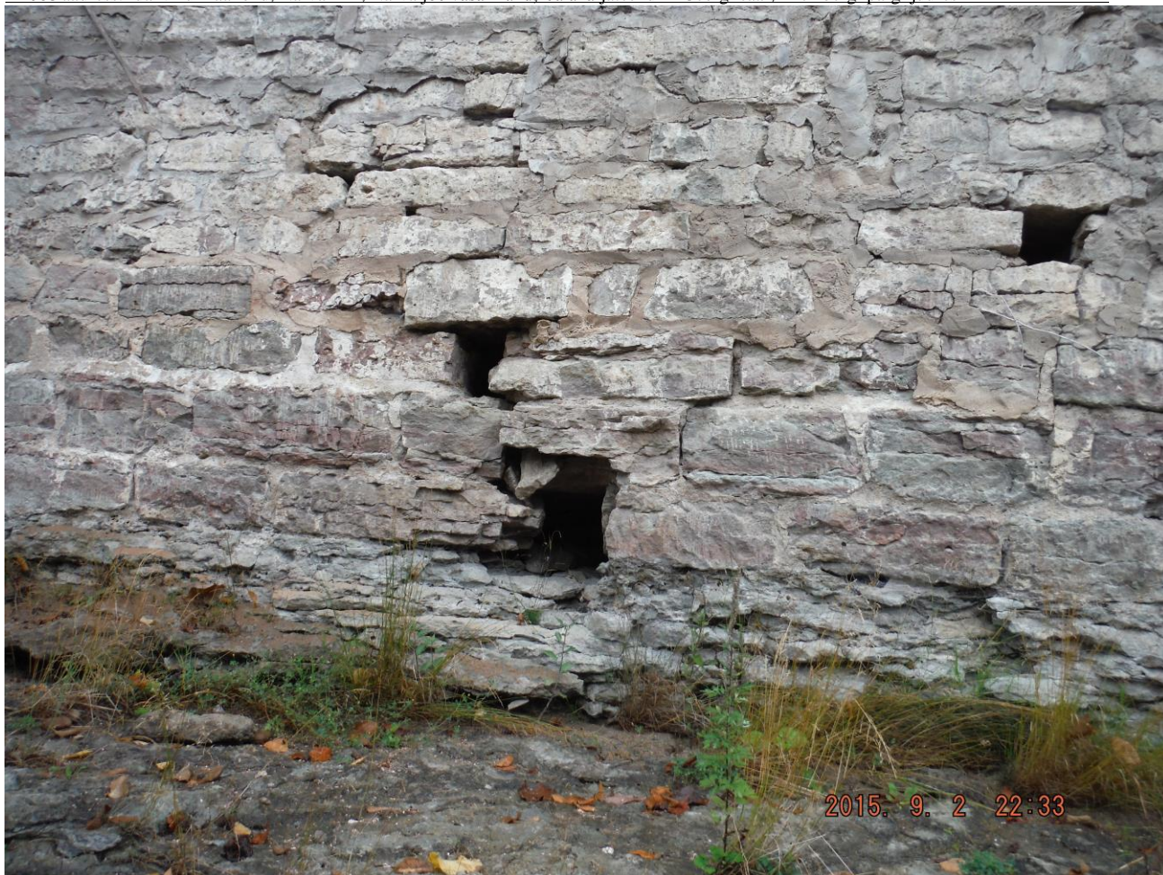
Foto 33. Autor F. S. Müüritise alumises osas on märgata hilisema remondi jäljed ja müürivoodri irdumise jälgi. Jäetud on vee väljavoolu avad. Müüritis on säilinud. Alumine osa on kuiv ja pinnasevee väljavool jõkke puudub.
