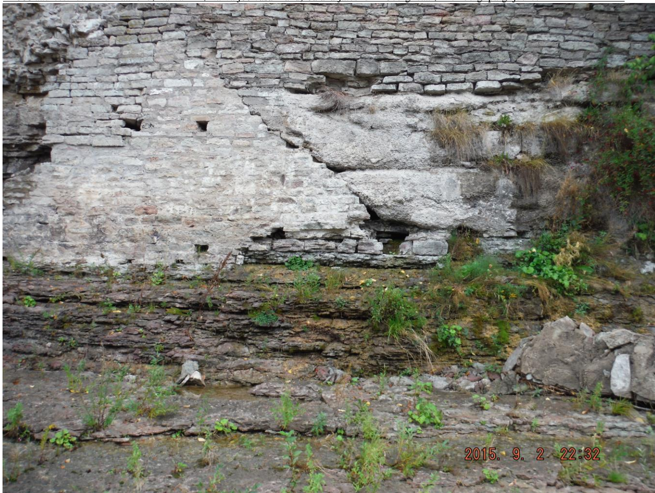
Foto 29. Autor F. S. Näide varasematest müüritise alumise osa parandustest. Alaosas on pinnasevee väljavool.
