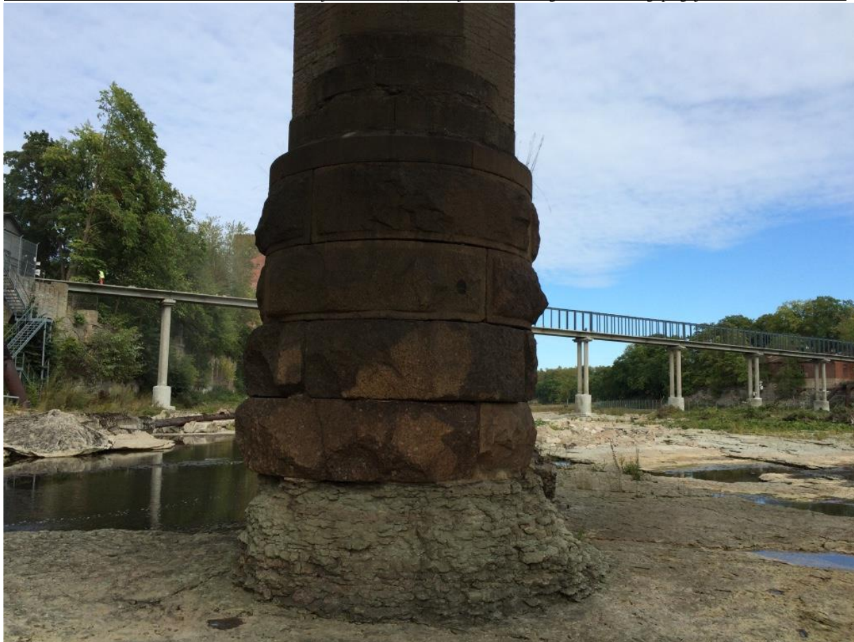
Foto 16.1. Autor Holger Karema (HK). Vee purustavat jõudu näitab sillasamba alune osa. Aastatega muutuvad sambad varisemisohtlikuks.
