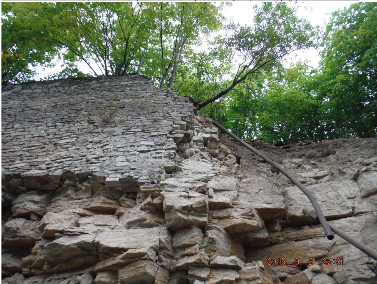
Foto 26. Autor F. S. Tugimüüri ülemine osa toetub kaljupinnasele. Vaadeldavas kohas ulatub kaljupinnas jõepõhjast palju kõrgele. Ca'40...70 sm paksune müüritis ei olnud piisav täitepinnasest tulevate jõudude vastuvõtmiseks.
