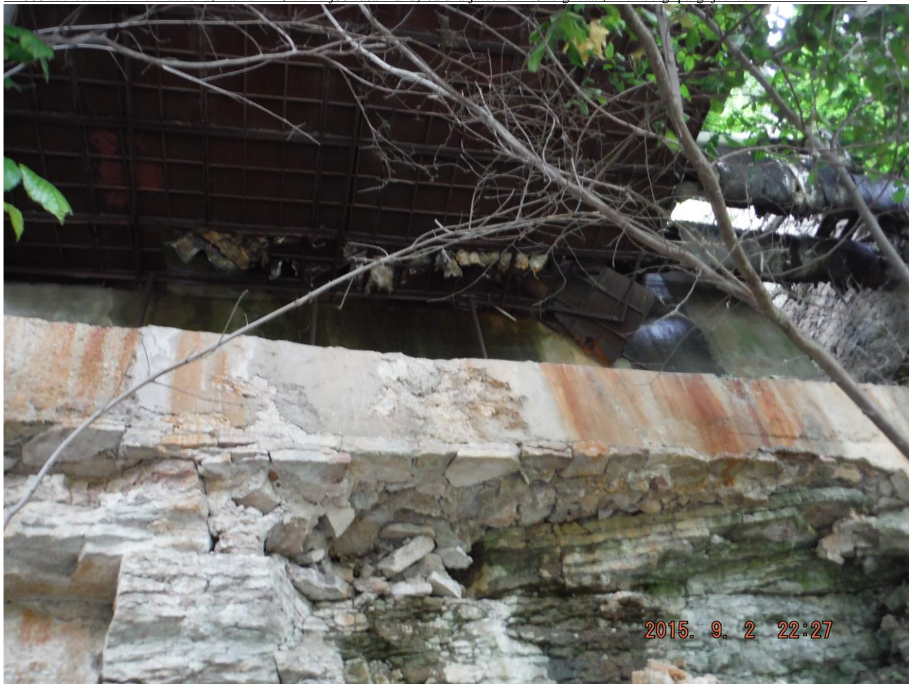
Foto 14. Autor F. S. Olemasoleva silla kaldatugi. Betoon on osaliselt murenenud.
