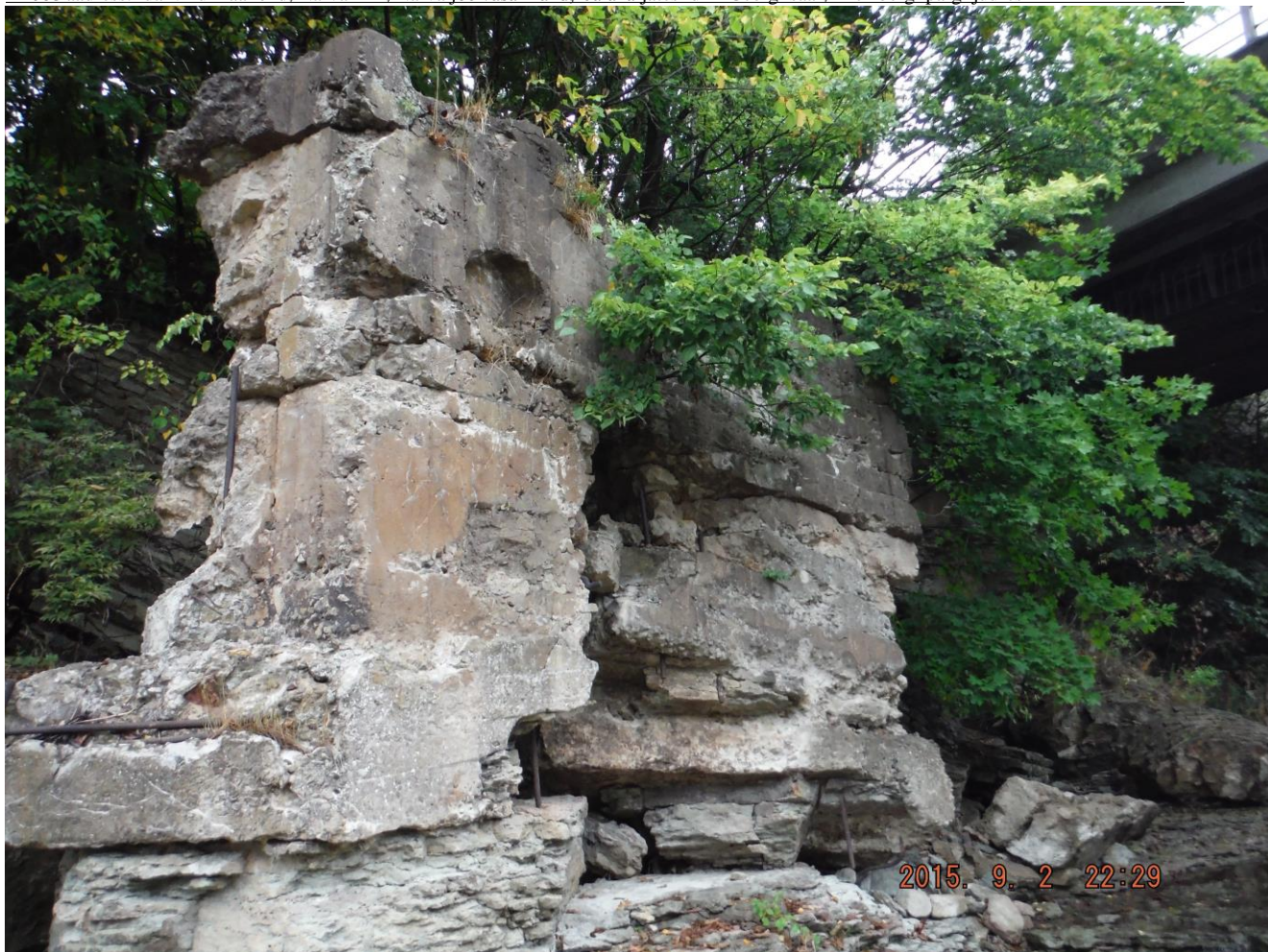
Foto 16. Autor F. S. Vana silla (20 sajandi ehitus) raudbetoonist tugi. On näha, et tugialuse murenemise peapõhjus on jää mehaaniline mõju, mis igal kevadel suure kiirusega voolab Narva jõe kanjonis.
