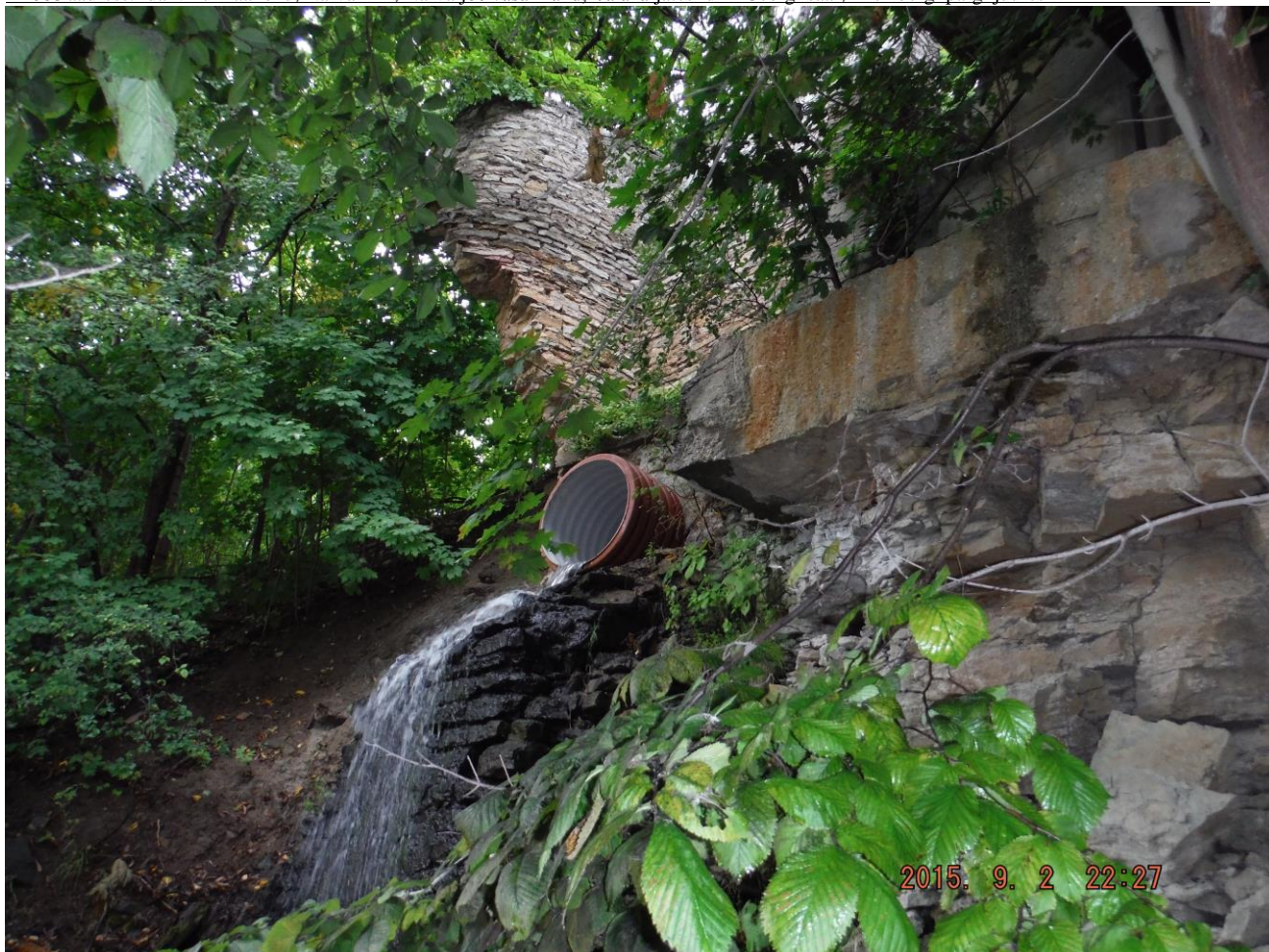
Foto 15. Autor F. S. AS Narva Vesi veepuhastusjaama toru d=1100 mm. Silla kaldaaluste varingute peapõhjuseks on vesi, mis voolab aastaringsest, jõudes klindi kihtide vahele ja murendab seda jäätudes ja sulades.
