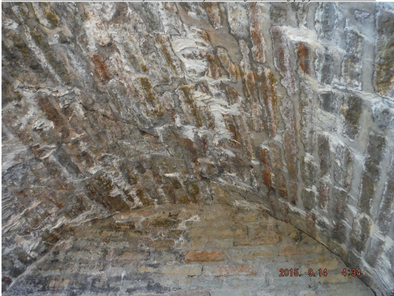
Foto 10. Autor F. S. Nõlva pind on kaetud lubjarikaste ladestustega. Praod nõlvas.
