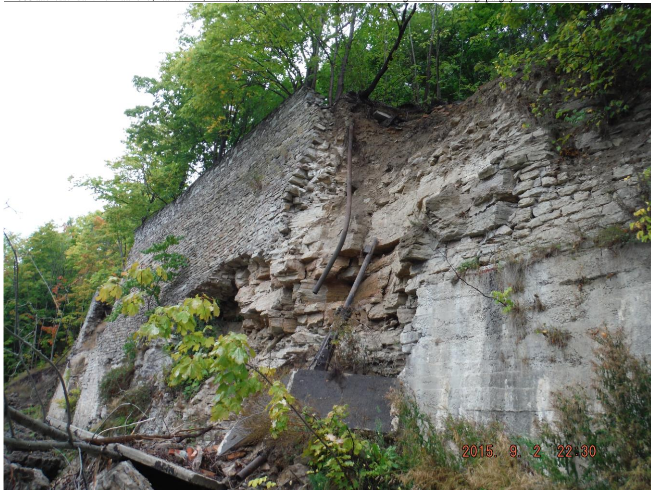
Foto 22. Autor F. S. Tugimüüri ühendamise kaljuga. On näha varisenud tugimüüri alumine osa. Tugimüüri sokli osa on ajutiselt parandatud (lapitud) betooniga.
