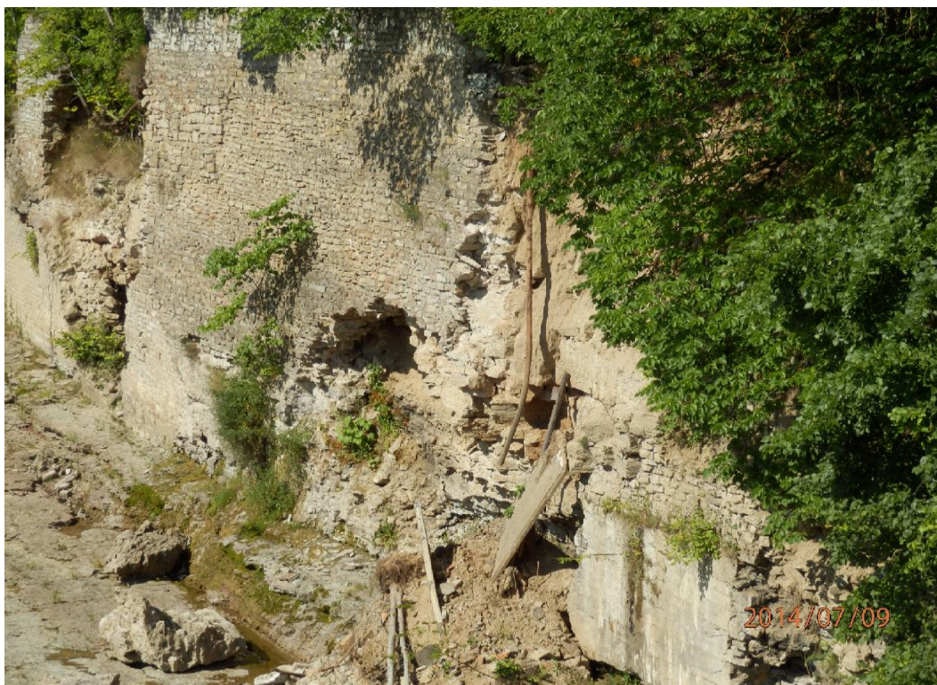
Joonis 4. Tugimüür 9. juulil 2014. a. Tugimüür on suures osas varisenud, säilinud müüriosa osaliselt pragunenud ja kohati on välja kukkunud kivid. On näha ka hiljutisi varinguid.
