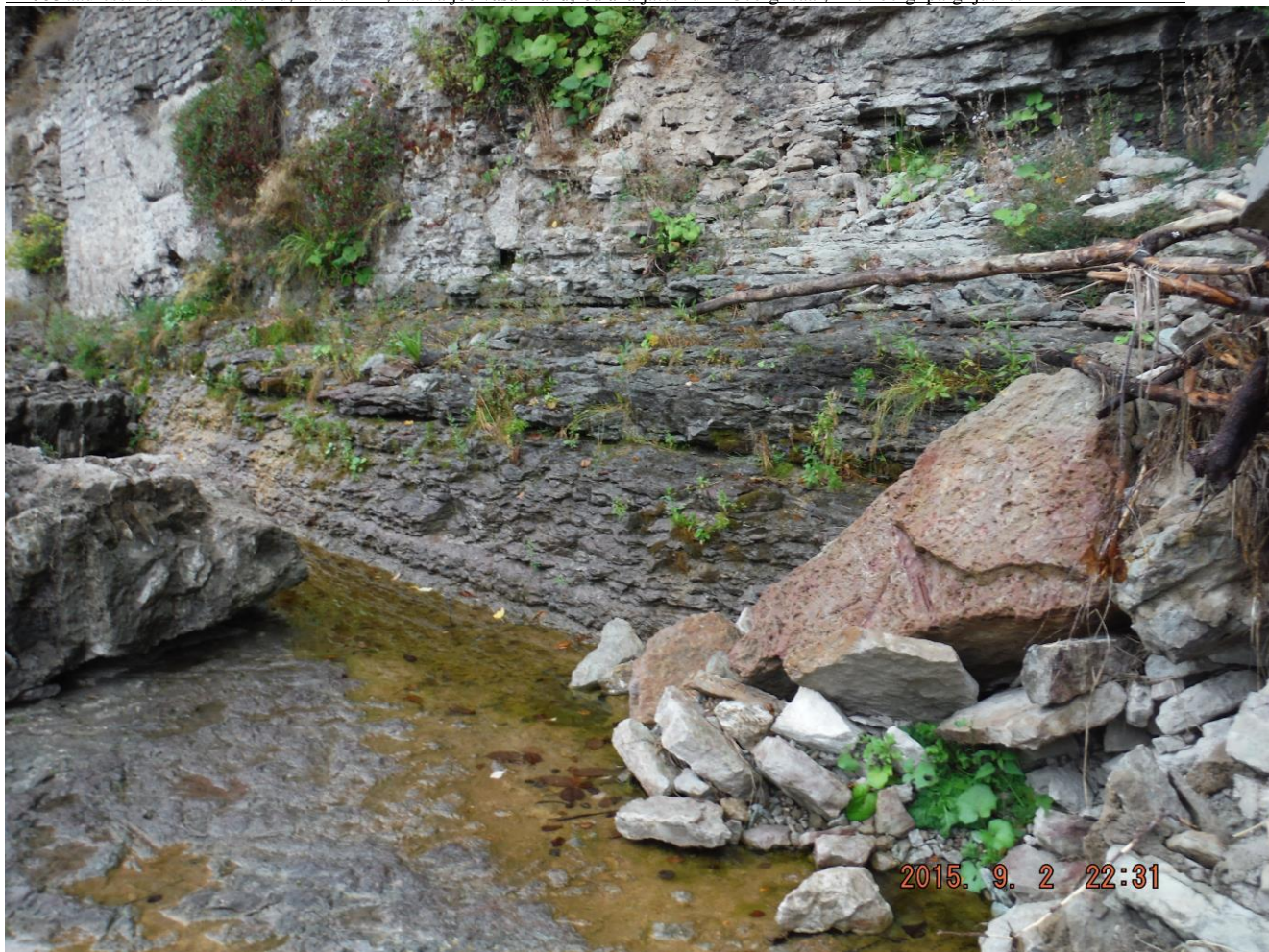
Foto 24. Autor F. S. Tugimüüri ja klindi kalju varingu all osas on näha pinnasevee intensiivne väljavool isegi pikal kuival perioodil.
