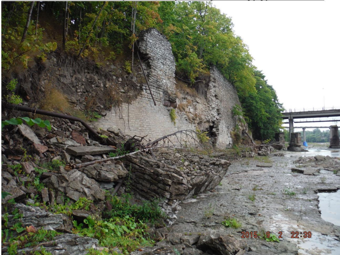
Foto 18. Autor F. S. Sein konstruktsioon paekividest lubimüürisel. Sein on osaliselt hävinud. Teostati müüri vertikaalsuse kontroll nõõrloodiga. Seinal pole nähtavat kõrvakallet vertikaalist.
