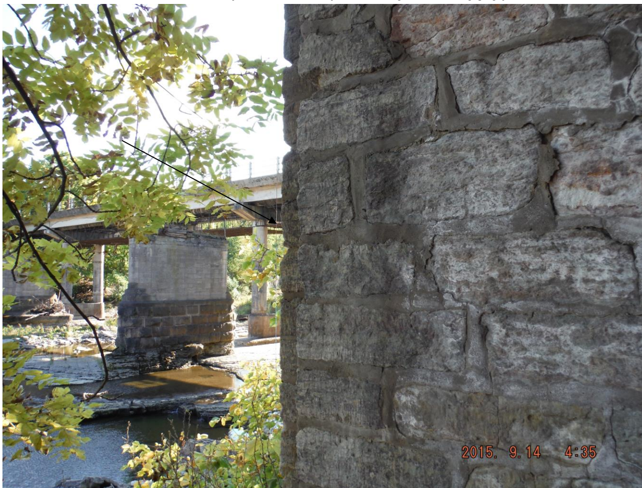
Foto 9. Autor F. S. Müüri vertikaalsuse kontroll nõorloodiga. Seinal pole nähtavat kõrvalekallet vertikaalist.
