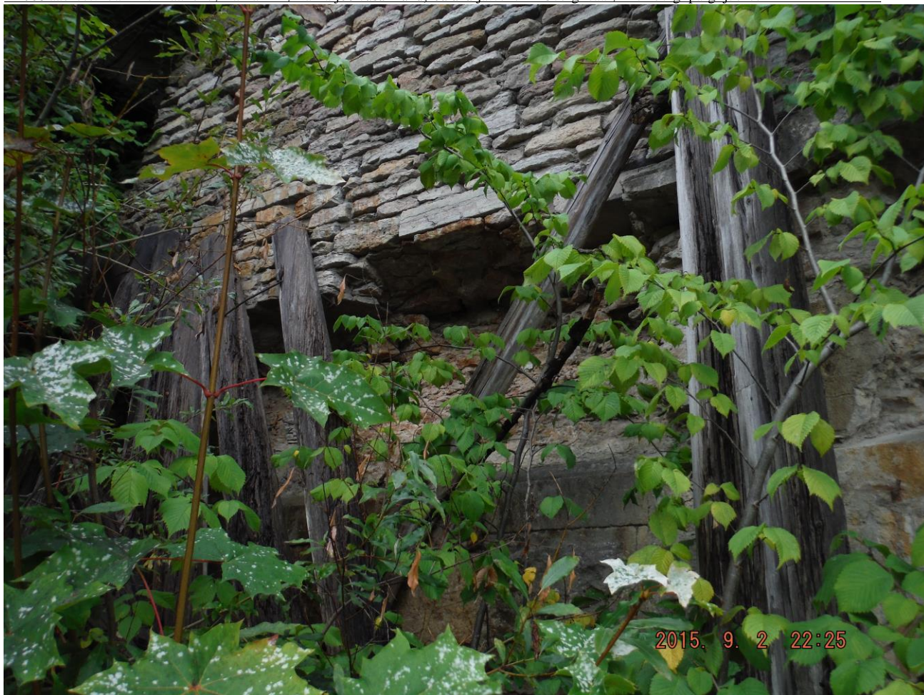
Foto 11. Autor F. S. Tugisein olemasoleva silla juures toetub vana silla alusele ja on raudkivist, tugevusega 34-42 MPa. Raudkivi alus on heas seisukorras, ei vaja parandamist. Tugisein on osaliselt varisenud, mis vajaks remonti ja taimkatte eemaldamist. Varisemise ohtlik koht.
