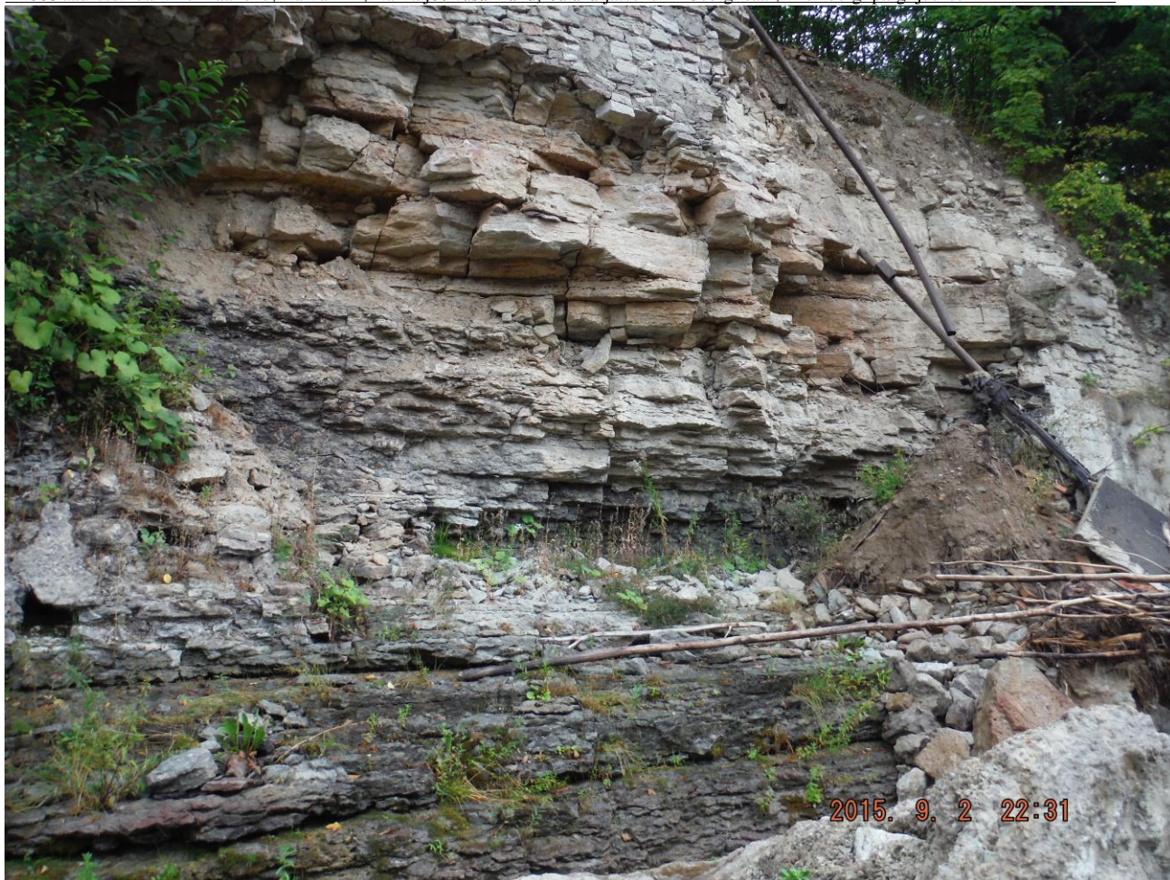
Foto 27. Autor F. S. Tugimüür on laotud vastu kaljut. All on pinnasevee väljajooks. Aastatega ei ole varisenud mitte ainult müüritise alaosa vaid on murenenud ja varisenud ka paekivist kalju.
