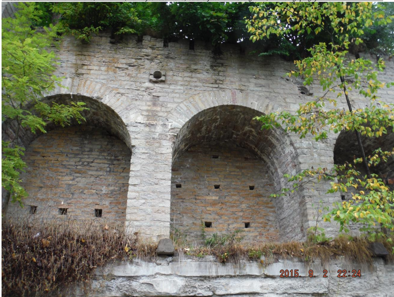
Foto 3. Autor F. S. Narva jõe kanjoni nõlva tugimüüri konstruktsioonid. Lubibetonist sokkel on osaliselt rikutud. Müüripind kaetud taimestikuga. Drenaažiaugud seinas. Paekivi tugevus 21-32 MPa, lubisegu tugevus 6-8 MPa, lubibetooni tugevus 7-11 MPa.
