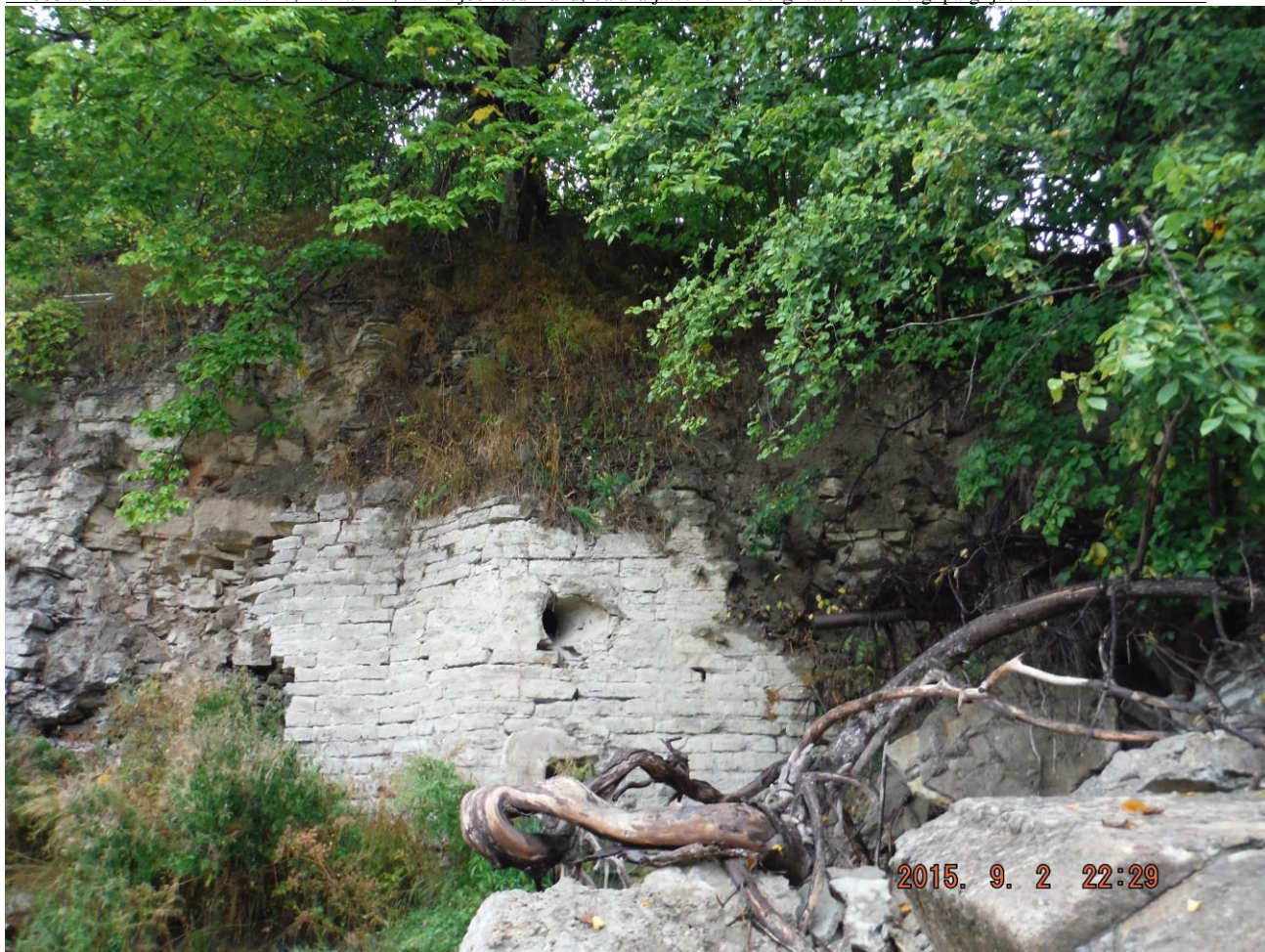
Foto 21. Autor F. S. Tugimüüri varemed. On näha, et tugimüür oli ühendatud kaljupinnasega. Lisaks koormustele pinnaselt ja kuhjuvast veest on müüritise lagunemisele kaasa aidanud ka elus loodus.
