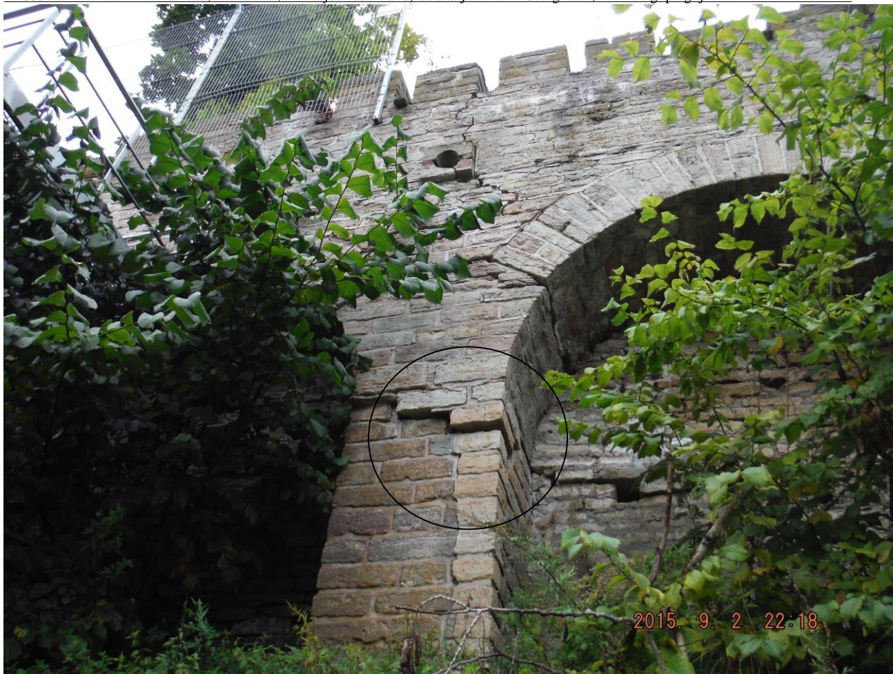
Foto 6. Autor F. S. Praod seinas ja nõlvas. Ülemine konstruktsiooni osa on liikunud horisontaalselt jõe poole. Tõenäoliseks põhjuseks on uue silla ehitusega rikutud pinnasevete väljavoolamine müüritise tagant. Maksimaalsed horisontaal jõud tekivad varakevadel, siis kui müüritis on jääs ja müüri taha koguneb lumesulamisest pinnasevett.
