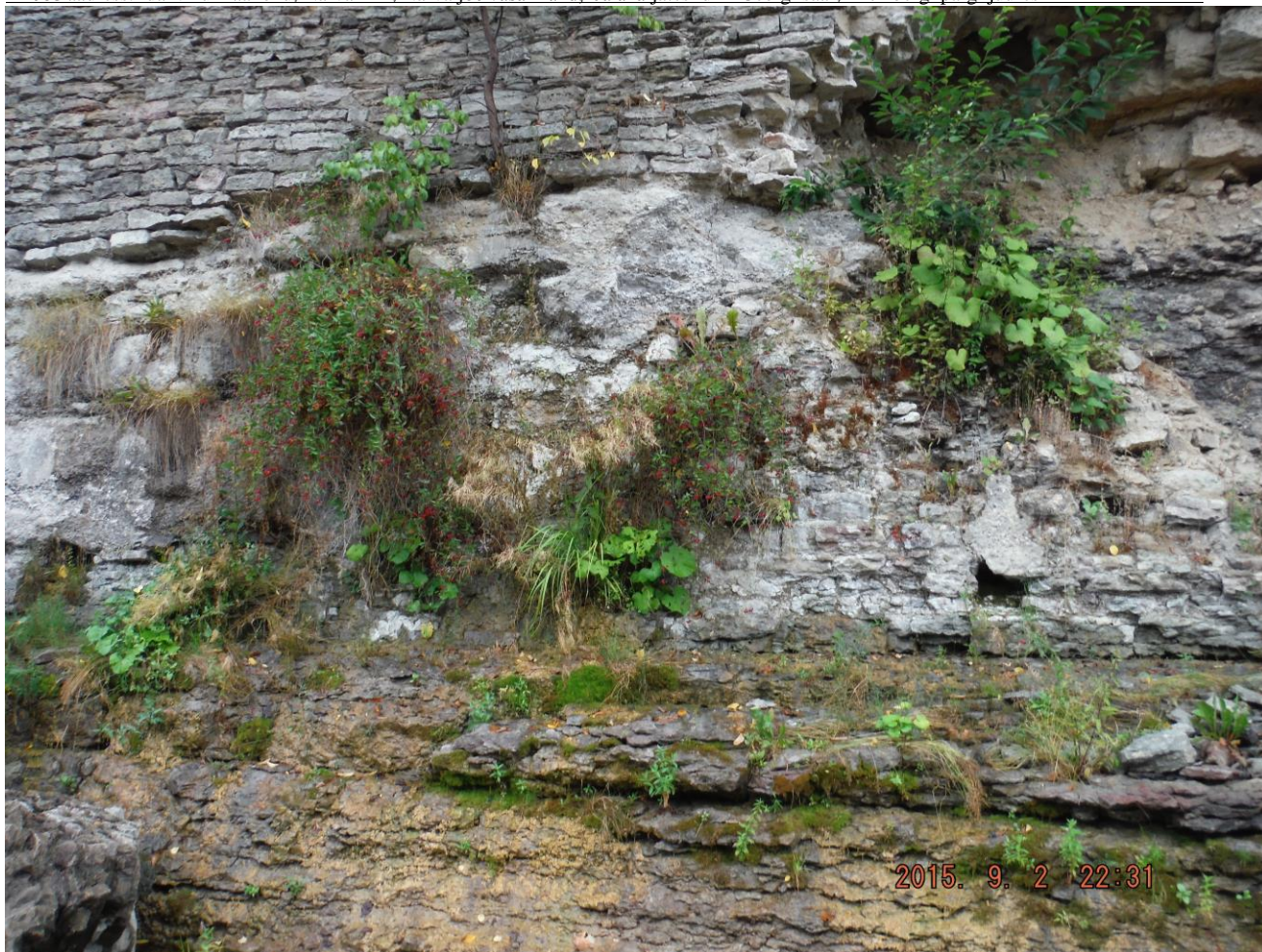
Foto 28. Autor F. S. Pinnasevee väljajooks kalju ja säilinud tugimüüri vahelt. Ilmekas näide vee ja jää purustavast jõust. Pinnasevee väljajooksu ülaosas, kus pinnas ei ole veega täitunud on müüritis säilinud.
