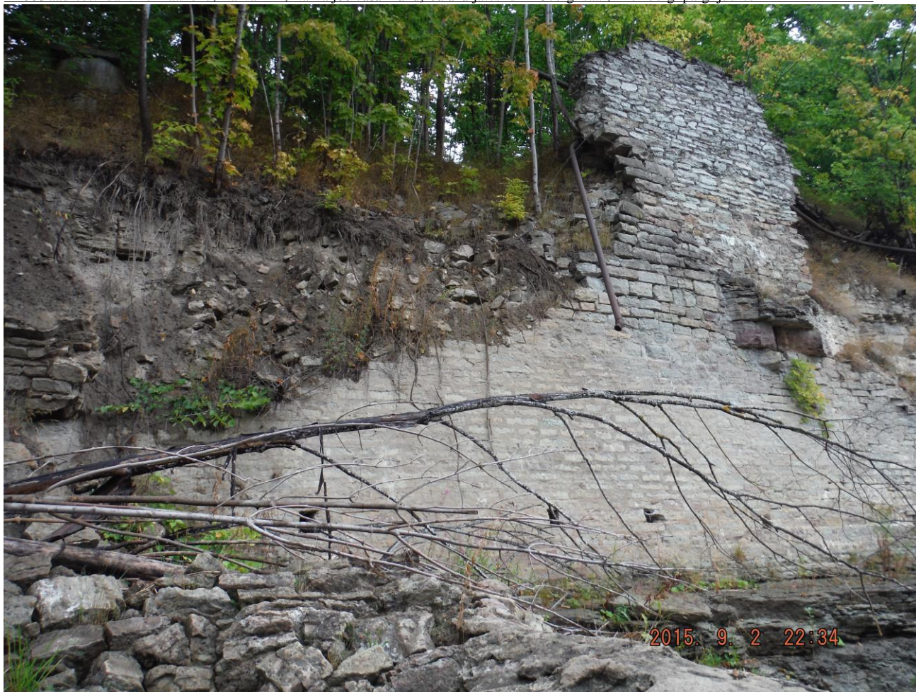
Foto 36. Autor F. S. Müüritise alumises osas on märgata hilisema remondi jälgi ja drenaazi aukke. Ülaosa on peale remonti uuesti varisenud.
