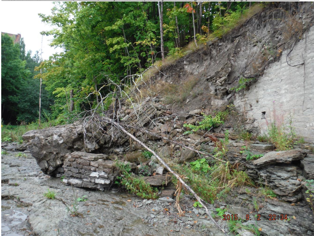
Foto 35. Autor F. S. Tüüpiline olukord: seal kus müüritise alt voolab välja pinnasevesi on üldjuhul müüritis ülaosas varisenud.
